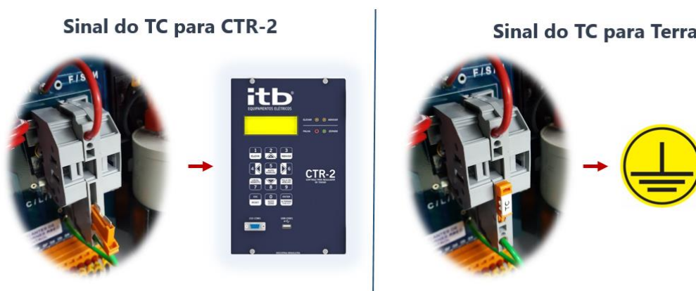
Figura 4: Procedimento para curto-circuitar o TC.
